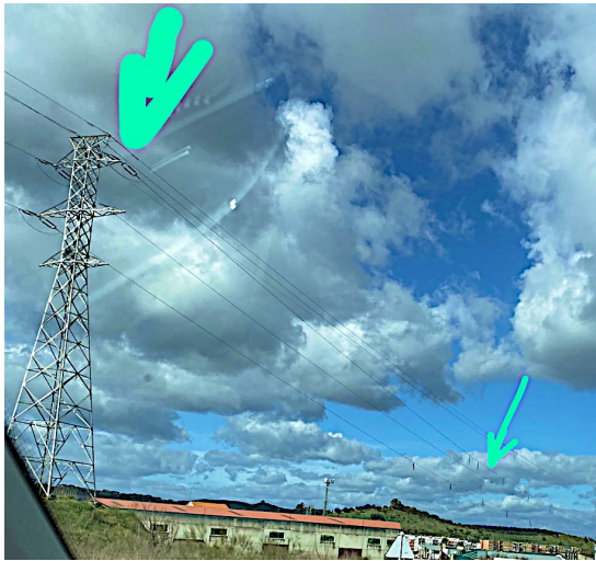
Fig. 113 Línea en proceso de duplicación. El apoyo admitirá tres cables más.
