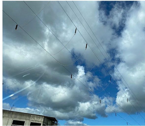
Fig. 114 Protecciones en un tramo de línea durante el tendido de los nuevos cables sobre una carretera.
