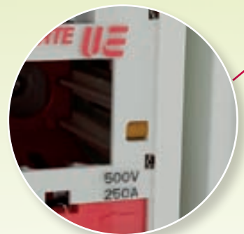
Detector de fusión, detecta la fase sin tensión.
