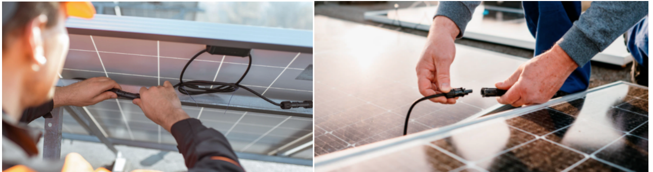
Fig. 28 Conectores estancos IPx4 para unir los latiguillos entre placas
