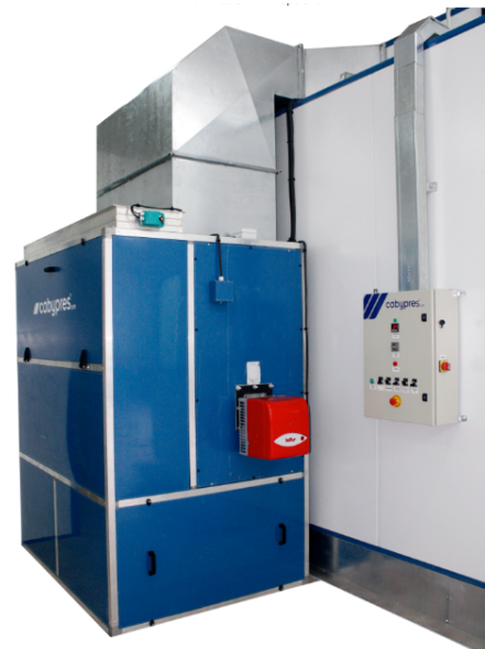
Fig. 4 Detalle del sistema de calefacción y ventilación, con el armario de control.
