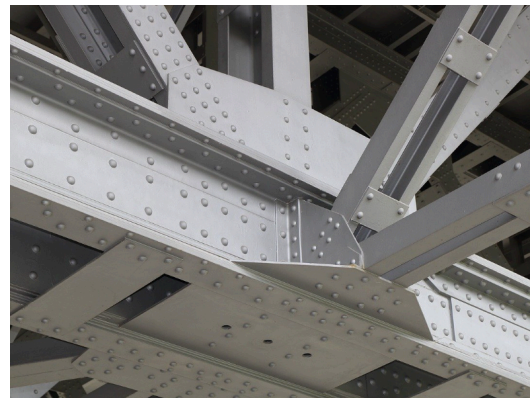
Fig. 56 Uniones remachadas
