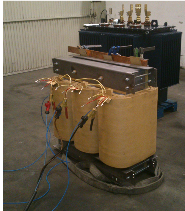
Fig. 53 Parte activa sin tapa de un transformador de distribución durante un ensayo de cortocircuito. [GED]
