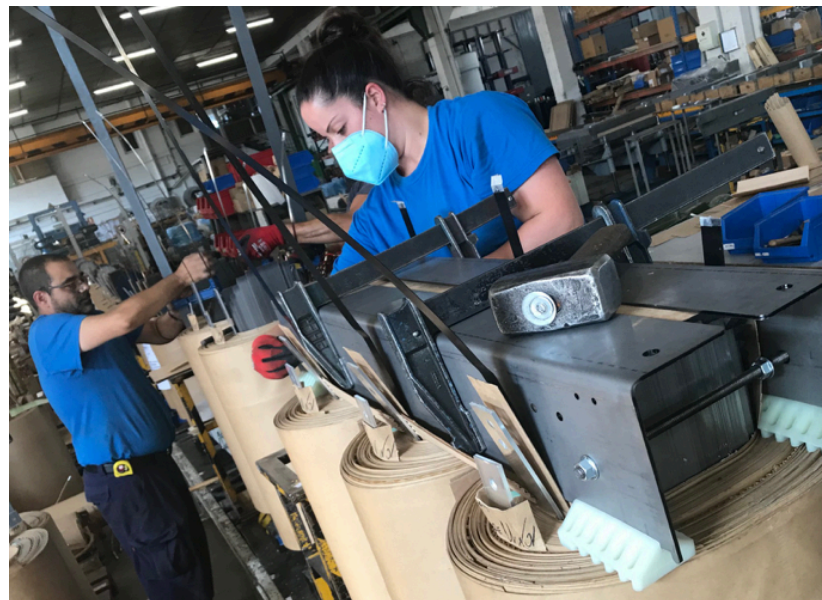
Fig. 71 Sobre el yugo de cierre del núcleo se colocan los separadores y la culata de refuerzo. [GED]
