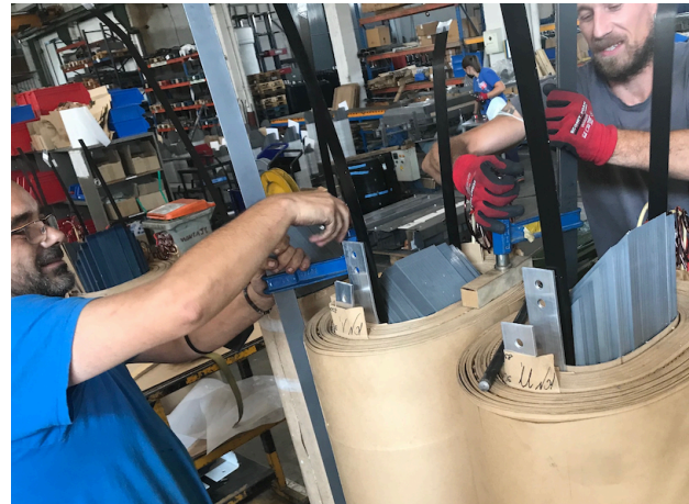
Fig. 70 Después se encajan a presión en las columnas del núcleo. [GED]
